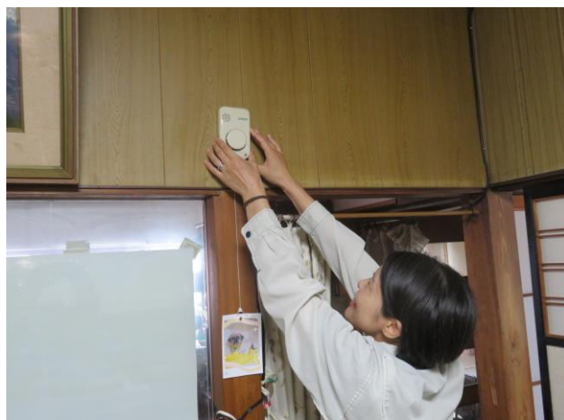
火災報知機の点検
