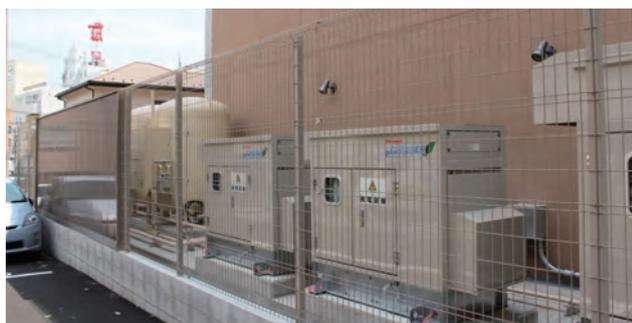
災害対応バルクは災害等により通常の配管供給ができない場合でも、直接ガス機器を接続して使用することが可能。非常用発電機による電力は、共用部の設備のほか、各住居にも1kW以内で供給される。
