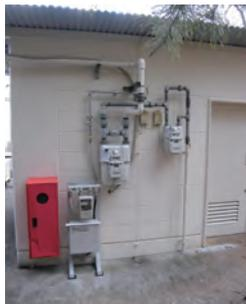
既設のバルク貯槽に取り付けることにより災害対応バルク化。(写真は高速道路のSAに設置されたもの)
