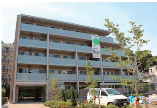
建物と地面との間に免震層を設置した、防災免震型マンション。地震による建物の揺れを小さくすることにより、建物の損壊や家具の転倒などの二次災害を防止。
